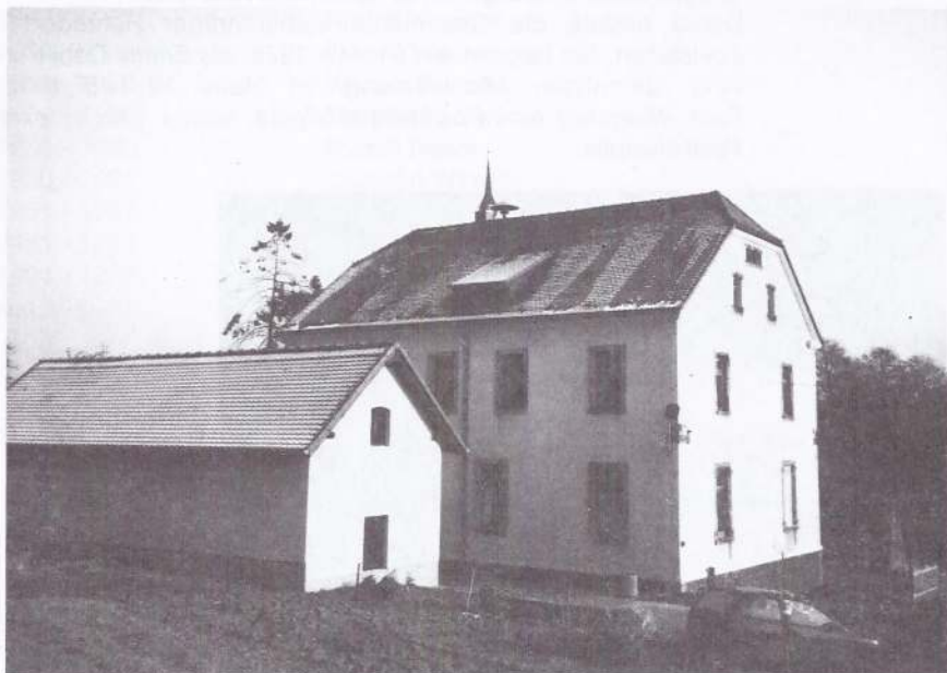
Bild 19 Schule 1995, Eingang, der ehemalige Eingang über die Schultreppe vom Schulberg aus wird nicht mehr genutzt
